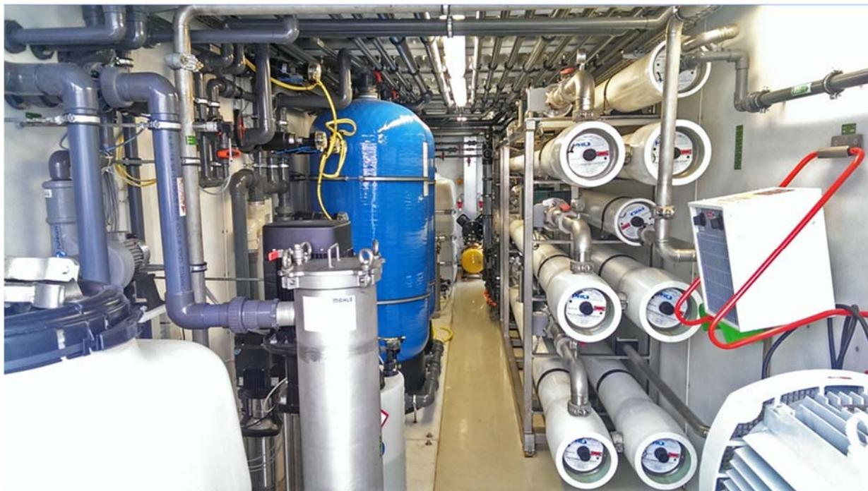
Рис. 16 - Внешний вид контейнерной Установки обратного осмоса по очистке фильтрата полигона
