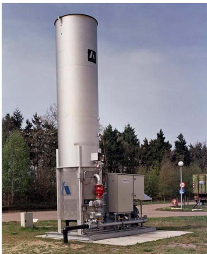
Рис. 10 – Газосжигательная установка
